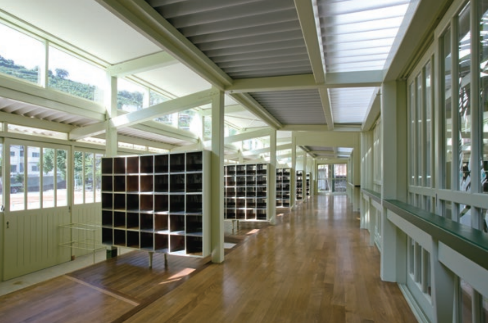
東校舎1階 昇降口・廊下
