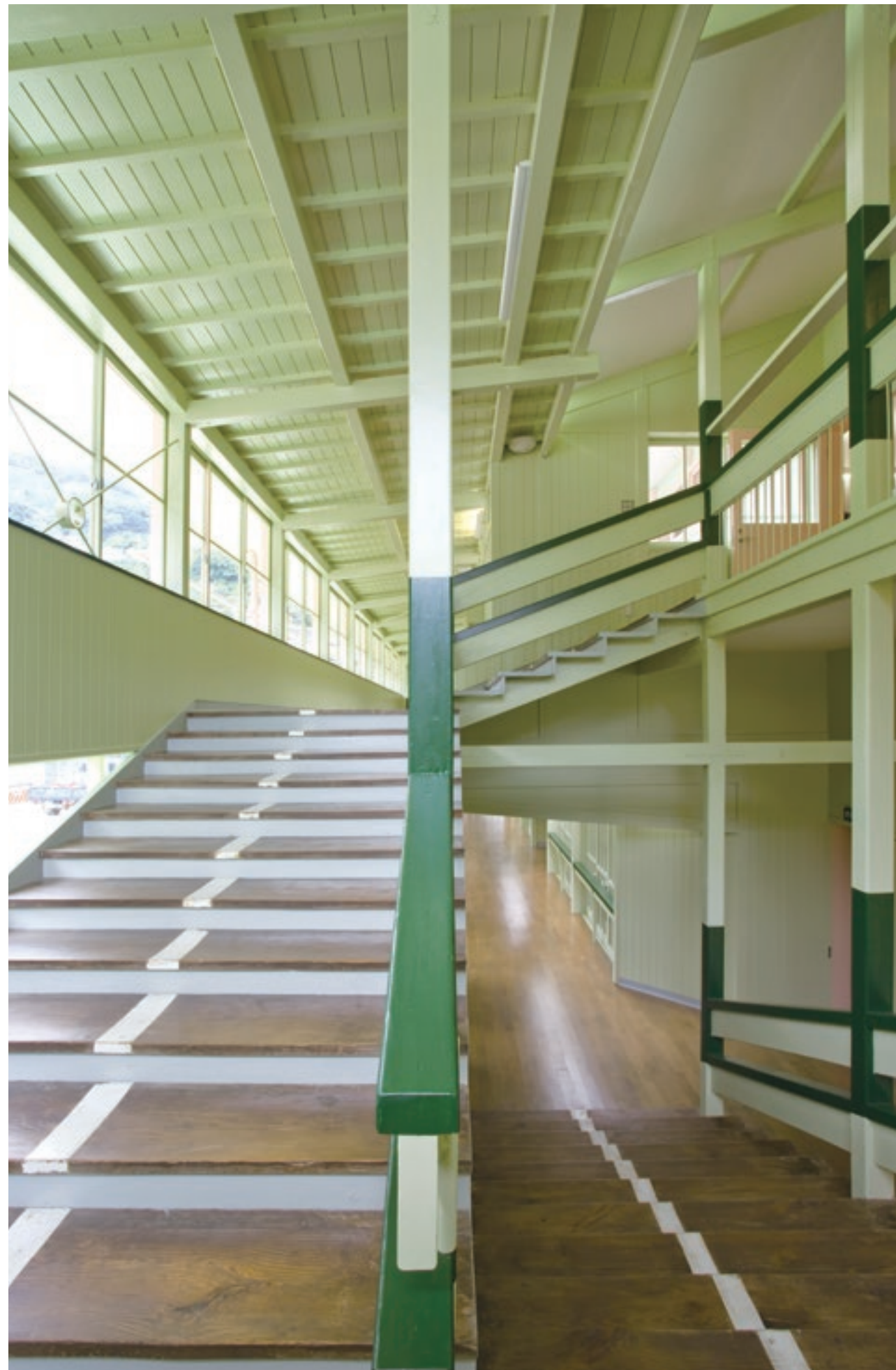
東校舎 階段室踊り場より
